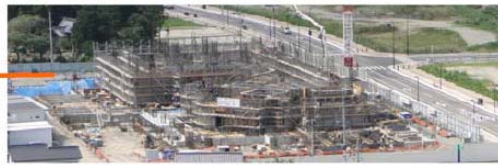
センター建設地(地上躯体工事段階)
